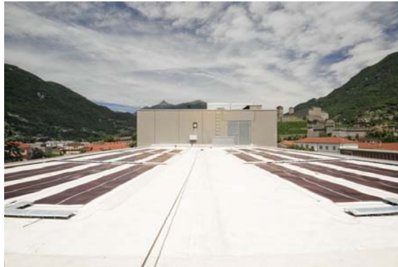
Flachdag PV-Anlage SCERRI , Bellinzona: SUPSI, AET, VHF Technologies
